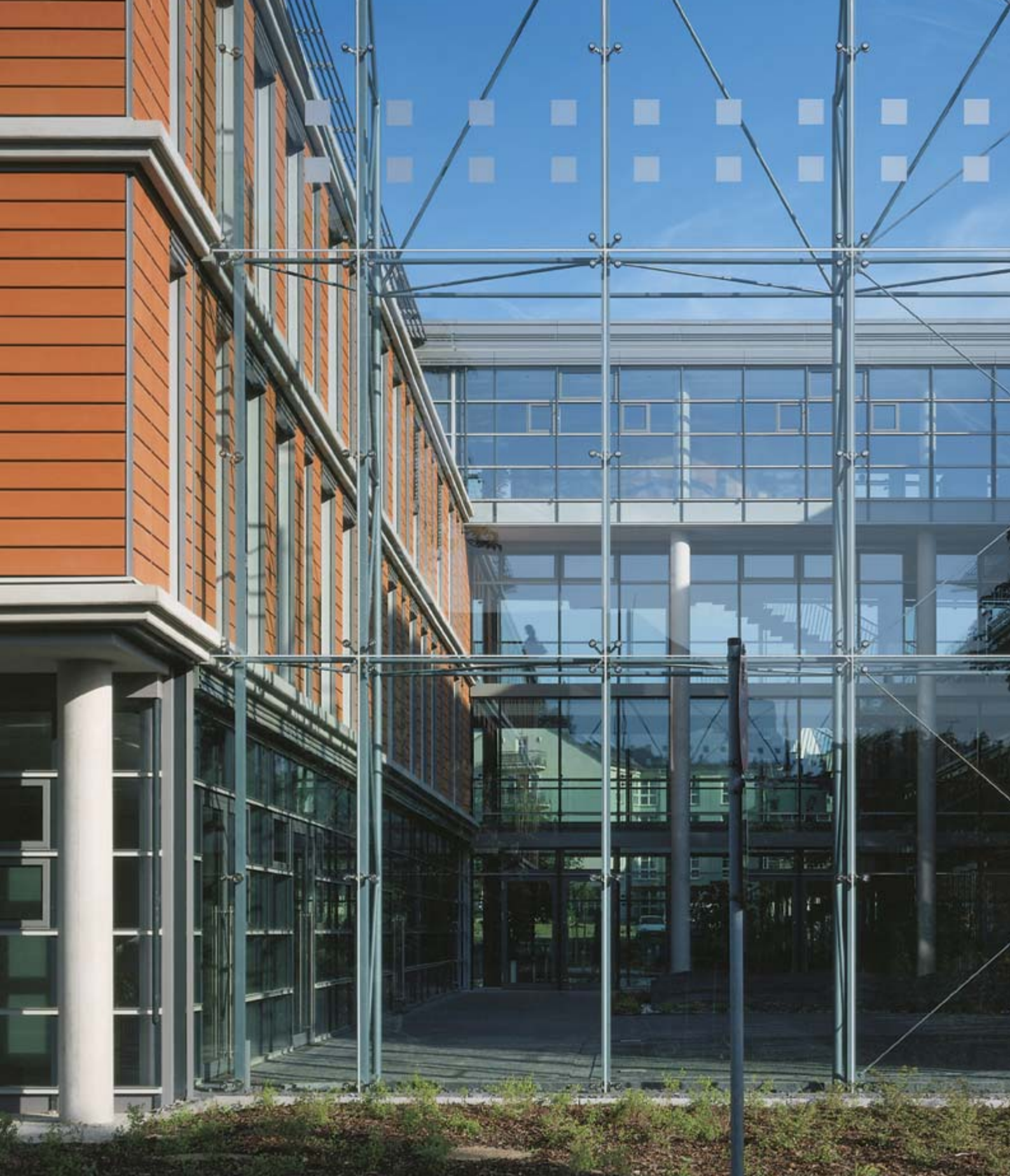
Hauptstelle der Sparkasse Vogtland, Plauen Architekten: OBERMEYER ALBIS-BAUPLAN, Plauen Farbe: ziegelrot Oberfläche: sandgestraht
