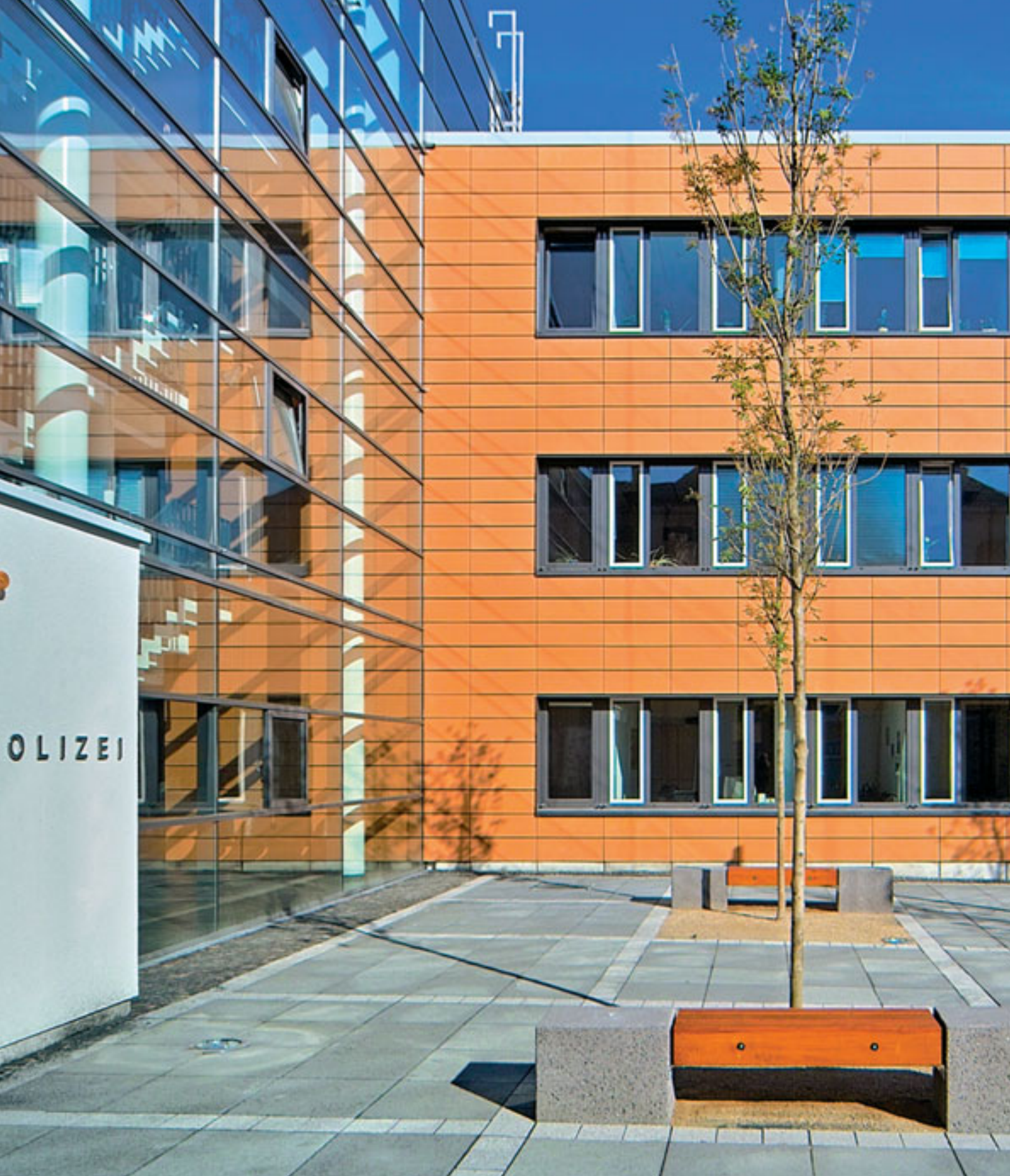
Здание полиции в г. Дилленбурге Архитекторы: Rohrbach & Schmees, г. Гиссен Цвет: кирпично-красный Поверхность: стандартная
