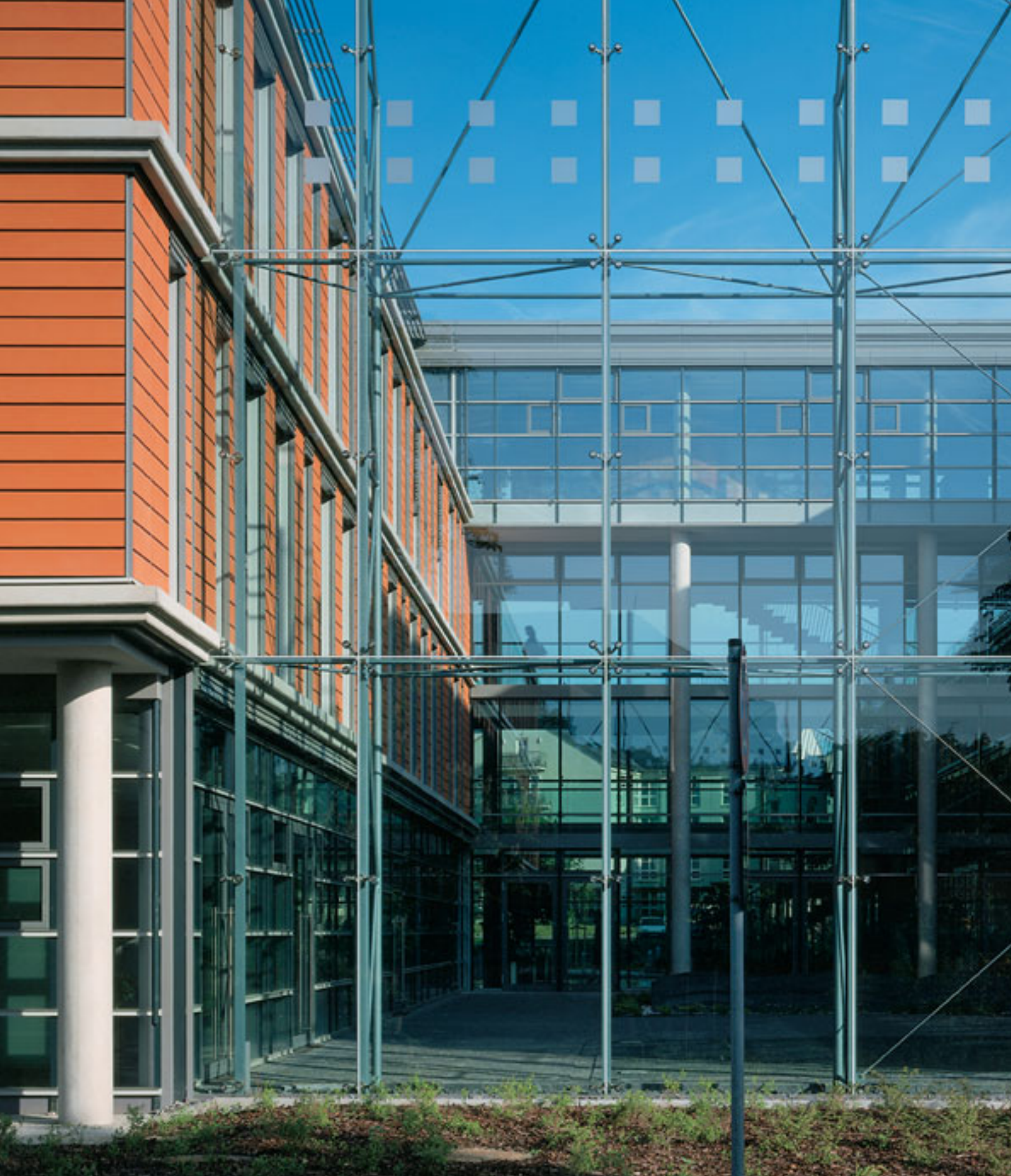
Центральное отделение сберкассы в Фогланде, г. Плауен Архитекторы: OBERMEYER ALBIS-BAUPLAN, г. Плауен Цвет: кирпично-красный Поверхность: подвергнутая пескоструйной обработке
